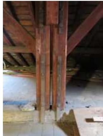
Fig. 33. Gare de 1861, comble, charpente à poinçons (système de murs, de plafonds et de poutres suspendus).
