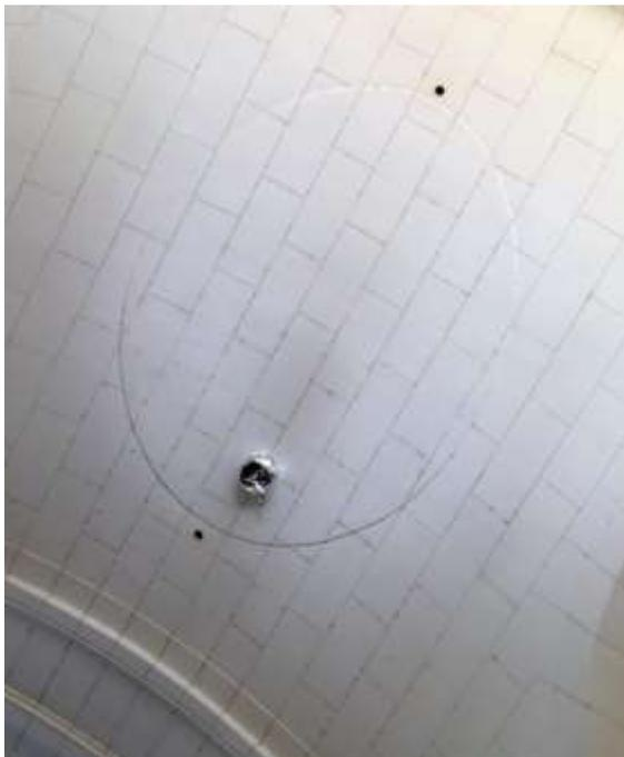
Fig. 63. L'une des deux verrières obturées au plafond du hall de la gare de 1909. Les deux orifices à chaque extrémité permettaient de suspendre des lustres (l'élément en métal brillant est un ballon d'enfant gonflé à l'hélium).
