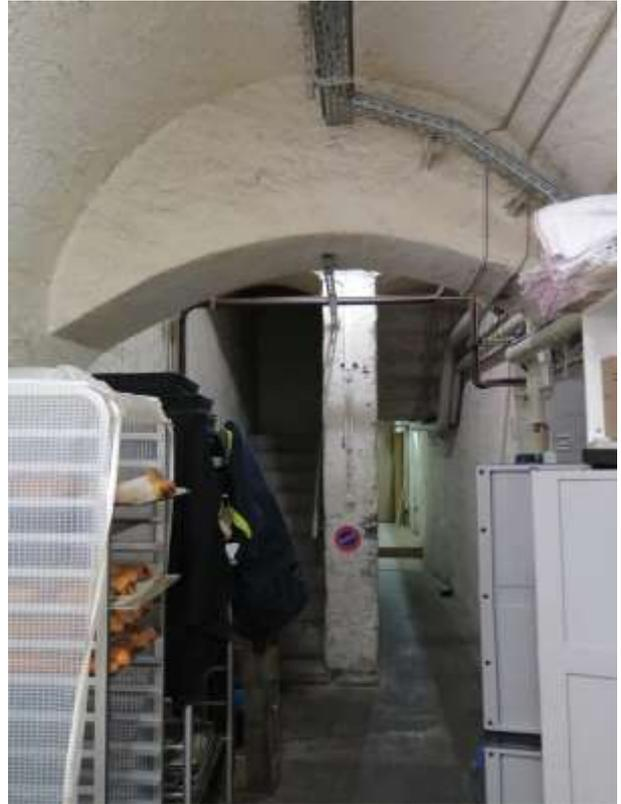
Fig. 20. Gare de 1861, sous-sol, escalier central avec arc de décharge, 2018.
