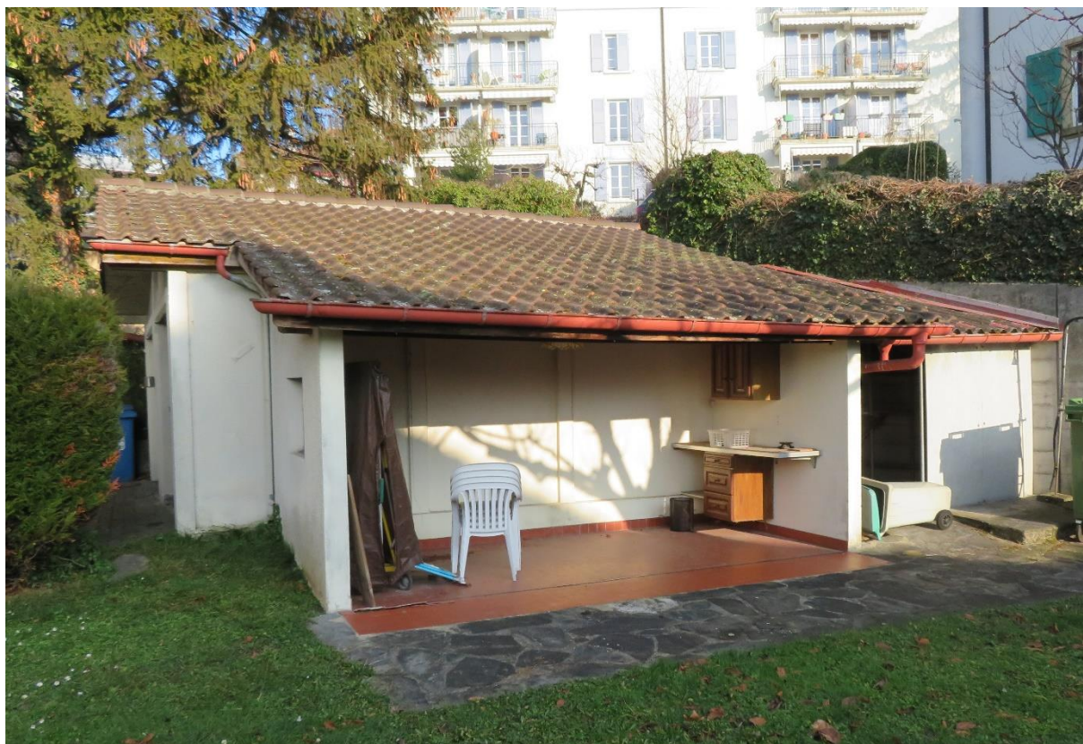
Fig. 28. Annexe et garage à l'est.
