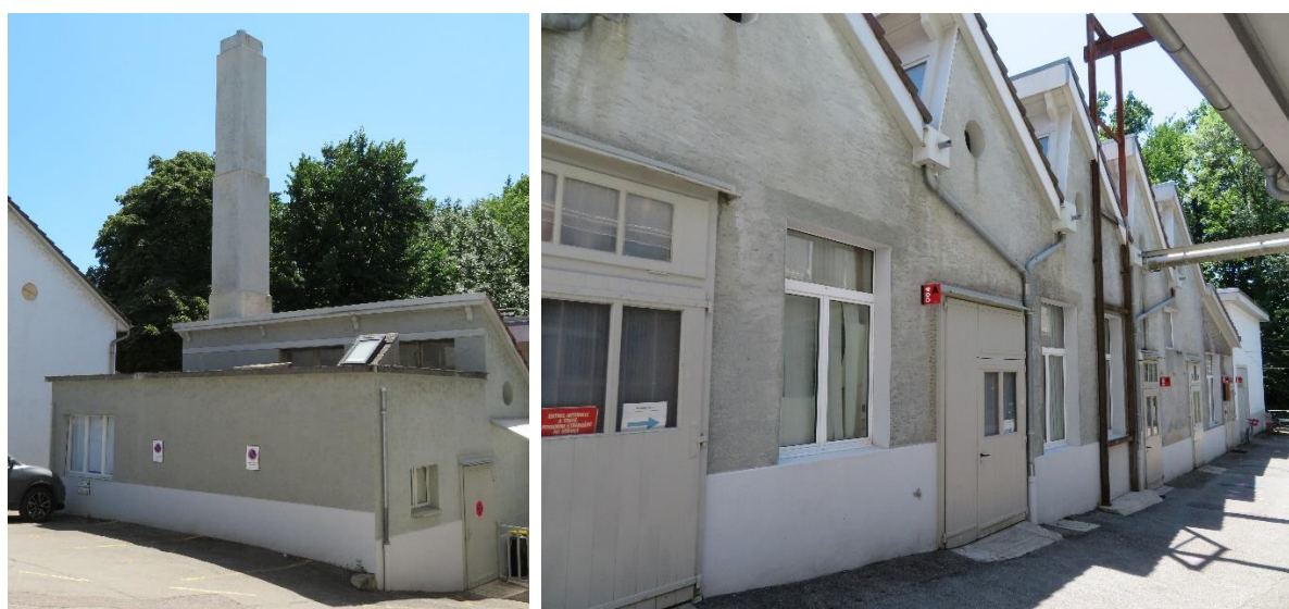
Fig. 32. Angle nord-est et face nord.
