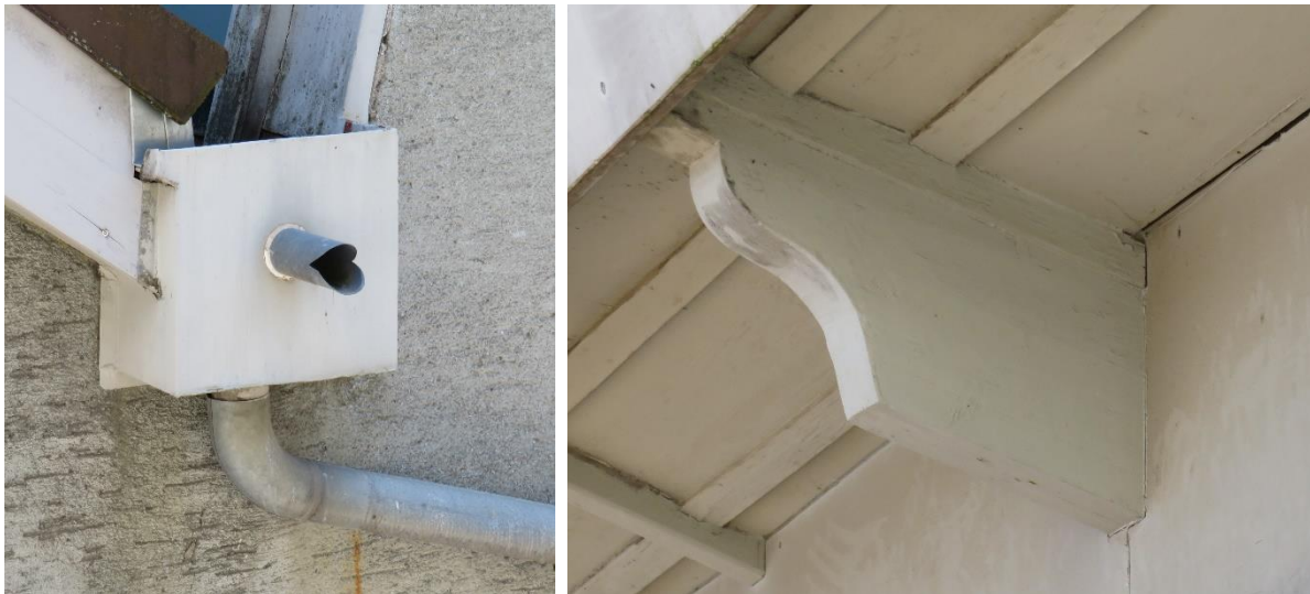
Fig. 34. Face nord, cheneau et tête de panne des sheds.
