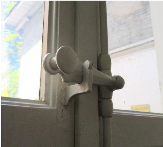
Fig. 27. Rez-de-chaussée, serrurerie des fenêtres nord.
