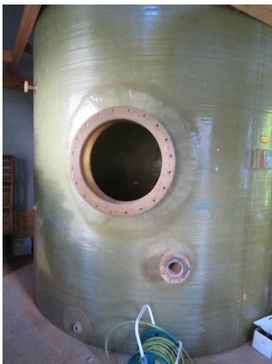
Fig. 21. Bâtiment n° 2902, intérieur.
