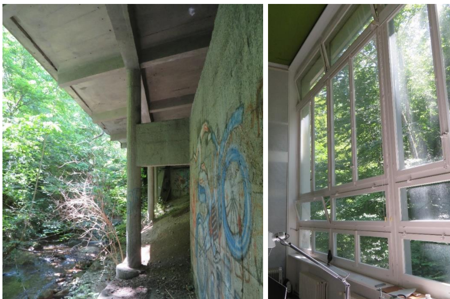
Fig. 35. Soubassement et local à l'extrémité ouest.
