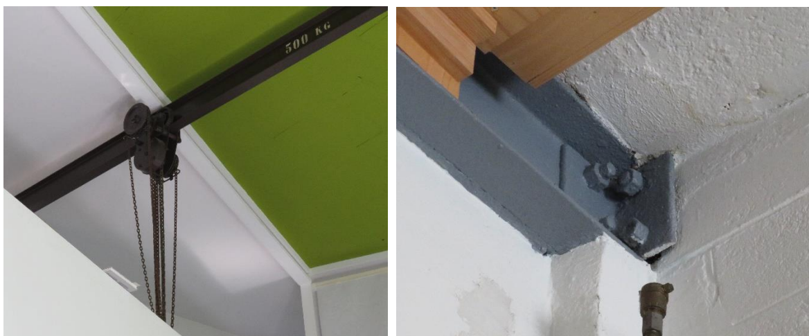
Fig. 36. Local à l'extrémité ouest, palan et charpentes métallique.
