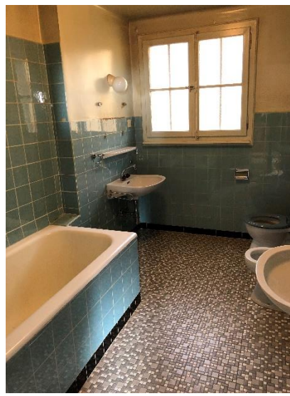
Fig. 17. Etage, salle de bains (2023).
