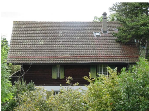
Fig. 10. Chemin du Village 42, façade est (2024).
