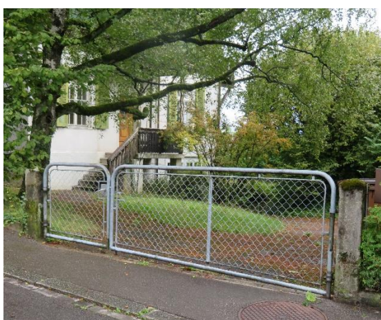
Fig. 24. Portail d'entrée au nord-ouest (2024).
