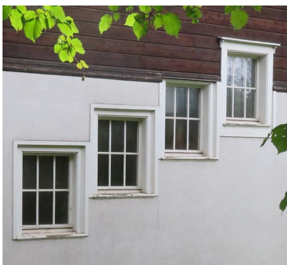
Fig. 18. Face nord, éclairage de l'escalier (2024).
