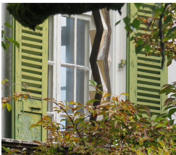
Fig. 20. Poteau soutenant l'auvent au-dessus de l'entrée principale (2024).
