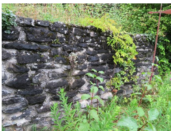
Fig. 25. Mur de soutènement au sud (2024).
