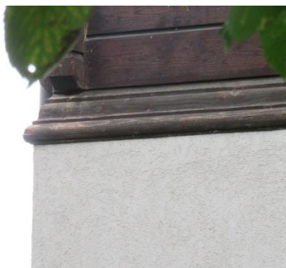
Fig. 22. Raccord entre le rez-de-chaussée et l'étage, face nord (2024).
