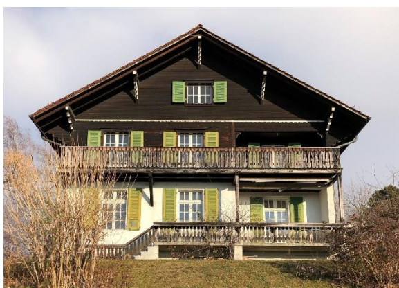
Fig. 8. Chemin du Village 42, façade sud (2023).
