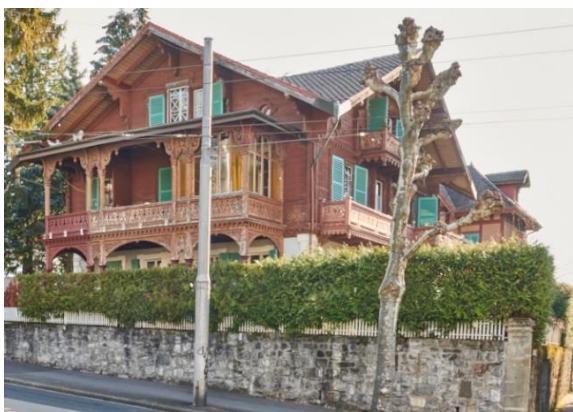
Fig. 26. Av. d'Ouchy 49, Lausanne (Recensement architectural du canton de Vaud).
