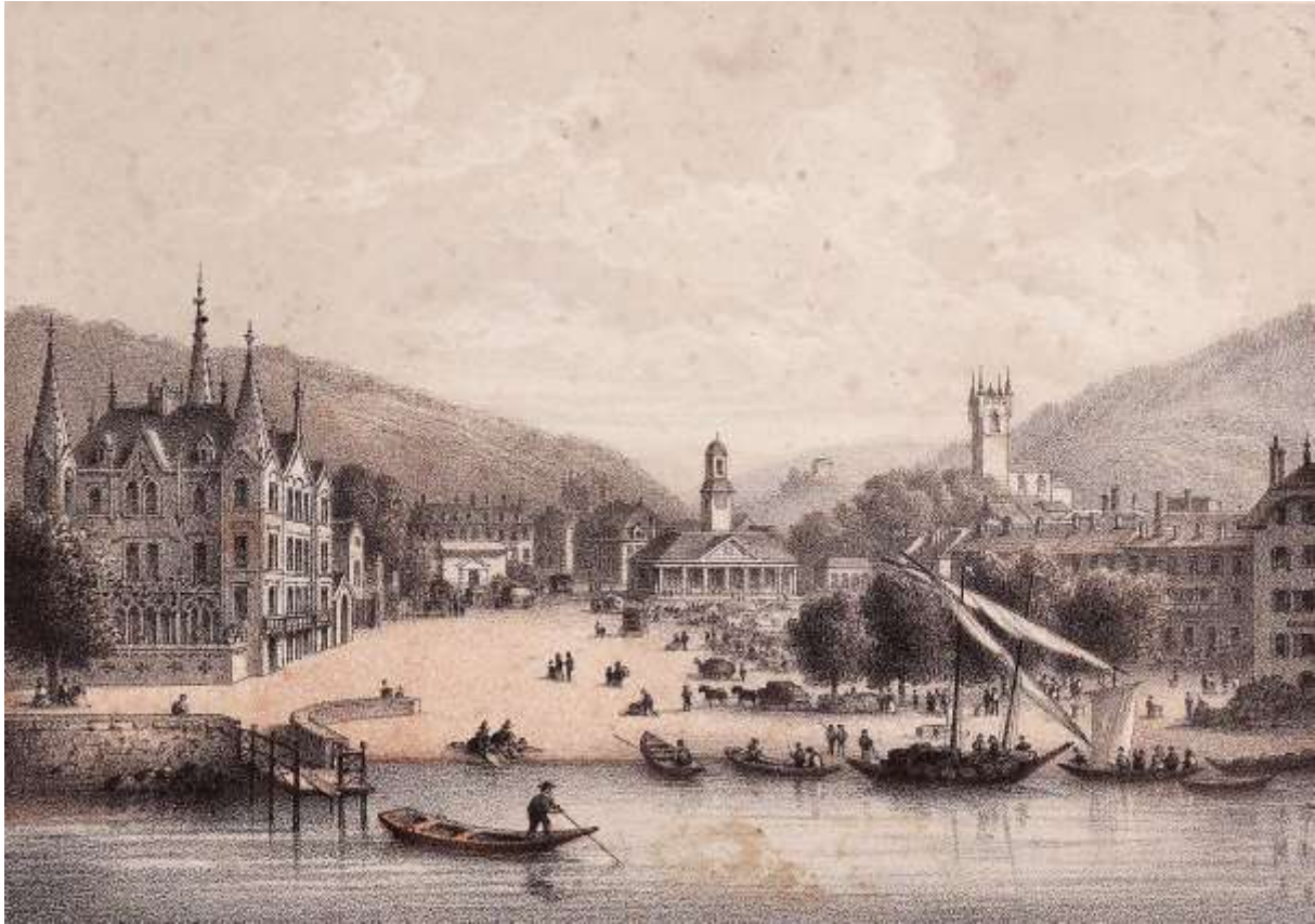
Fig. 20. La place du Marché après la reconstruction du château de l'Aile en 1846, d'après E. Lafon (MHV, 1432-00). Le débarcadère apparaît avec plus de détail que sur d'autres estampes. Il est flanqué de deux murs et composé d'une charpente en bois.
