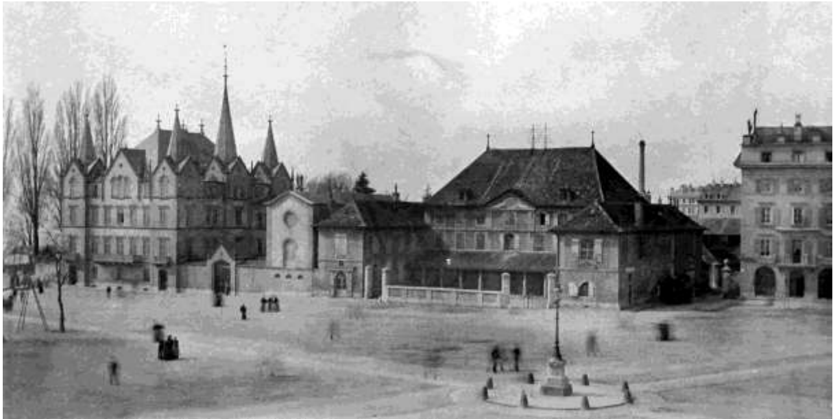
Fig. 26. La place du Marché entre 1875 et 1896 (MHV). En-bas à droite, le candélabre installé en 1875, avec éclairage au gaz et huit bornes boute-roues.
