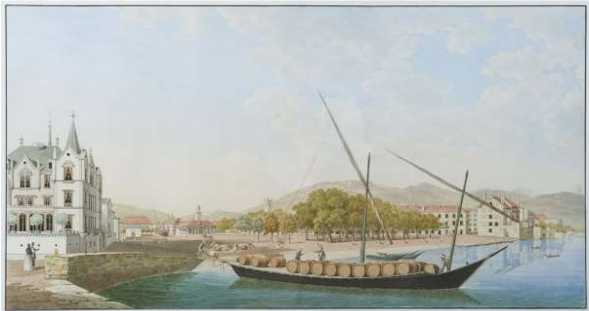
Fig. 19. Marius Steinlen, la place du Marché vers 1850 (MHV, 5195). Marius reprend exactement le même sujet que son frère Théophile en 1829, en le modernisant (fig. 16). A gauche, la maison de l'Aile a été reconstruite en style néogothique en 1846. En revanche, le bateau est demeuré inchangé, ainsi que le mur et la jetée.
