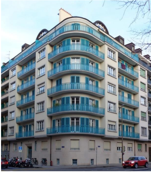
Fig. 6. Rue Henri-Mussard 19, architecte John Torcapel, 1929 (photo F. Python, RAIM).
