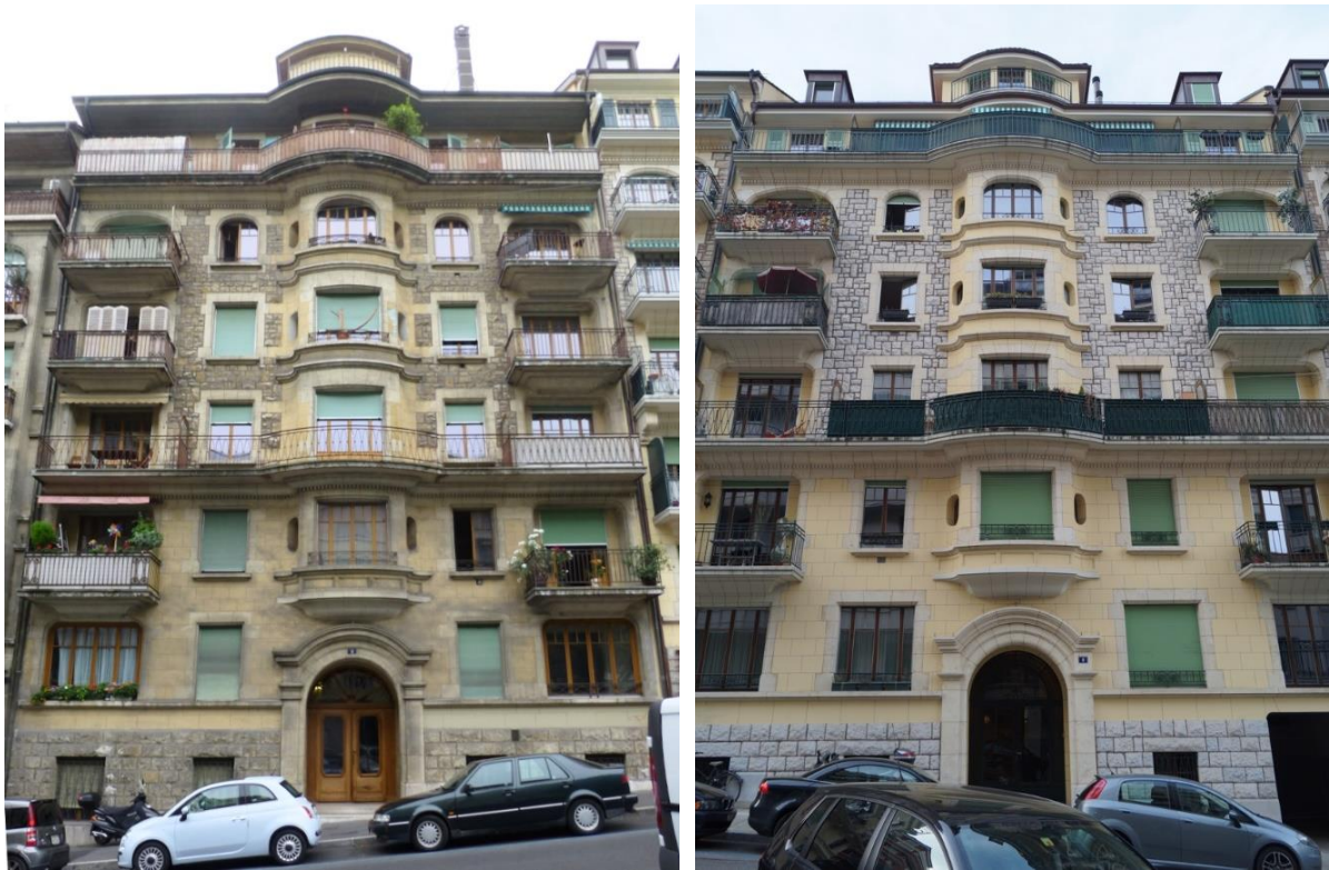
Fig. 5. Rue Henri-Mussard 5 et rue Gustave-Muller-Brun 4, architecte Paul Perrin, 1925 et 1928 (photos F. Python, RAIM).
