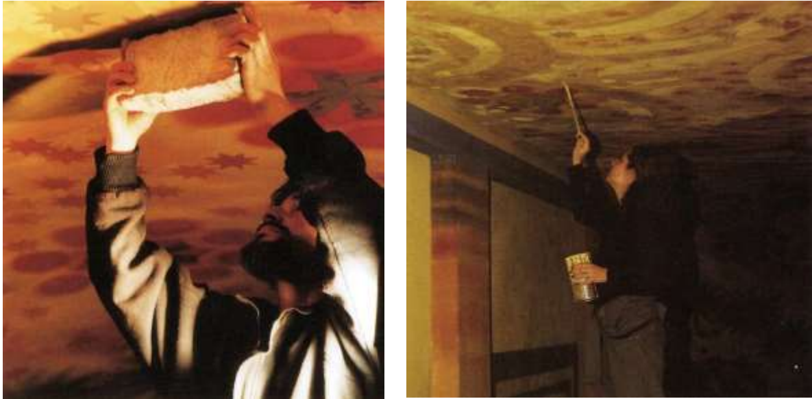
Fig. 20. Technique de restauration : nettoyage préalable de la pellicule de saleté avec une éponge en latex Whishab, puis retouches et consolidation.
