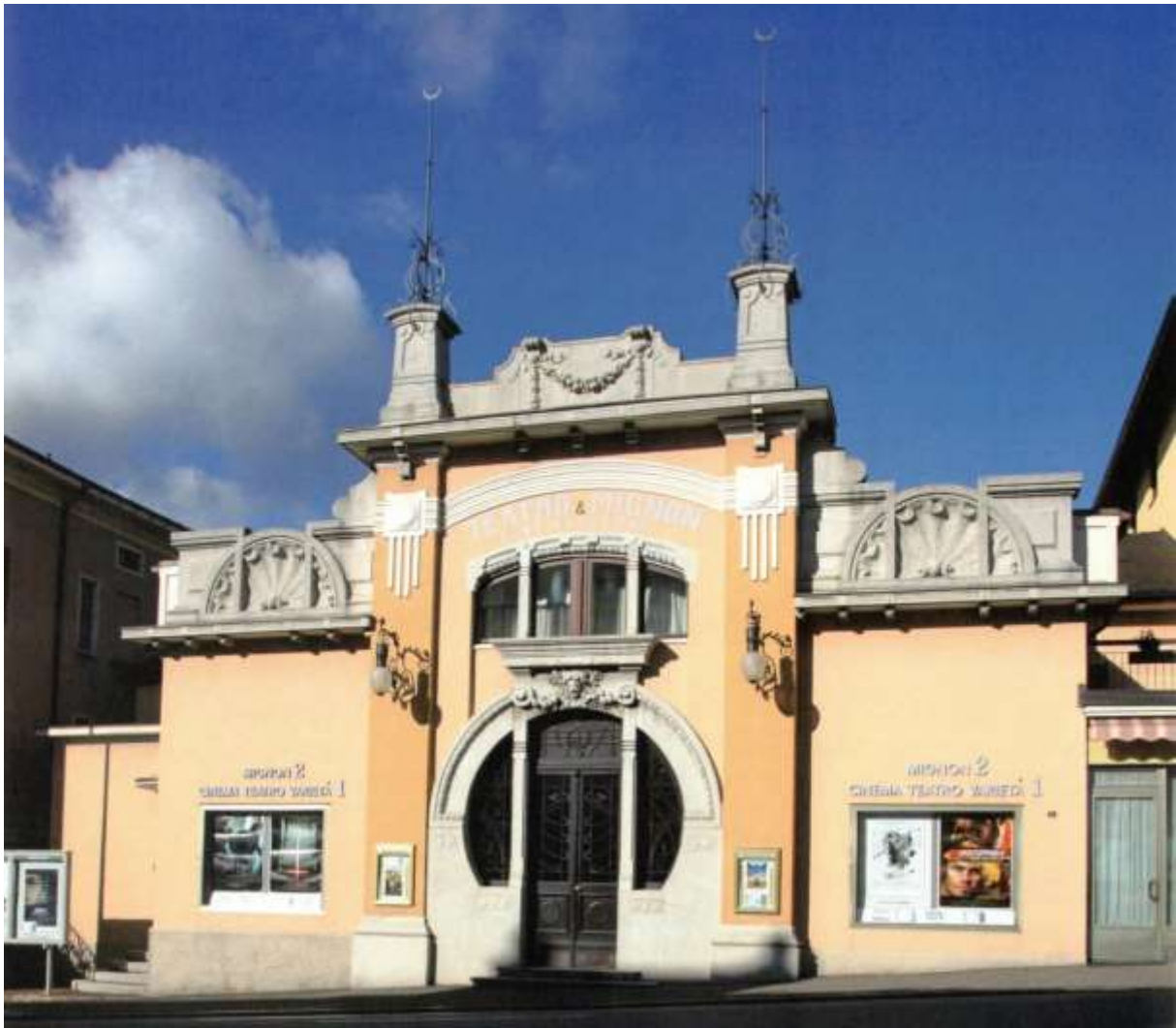
Fig. 17. Cinéma Mignon, Mendrisio, 1908 (EDELSTEIN, op. cit. , p. 182). L'intérieur a été complètement transformé et ne comporte plus de trace historique.
