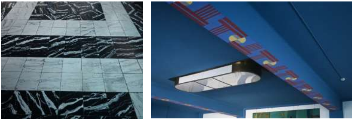
Fig. 21. Hall d'entrée après restauration (photos Fabio Pedrina et Mauro Galfetti, 2022).
