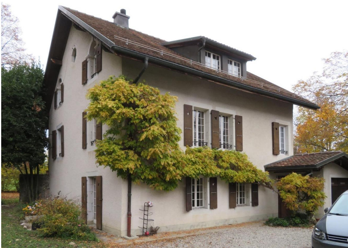
Fig. 19. Maison ch. de Prélaz 17, faces sud et ouest (novembre 2025).
