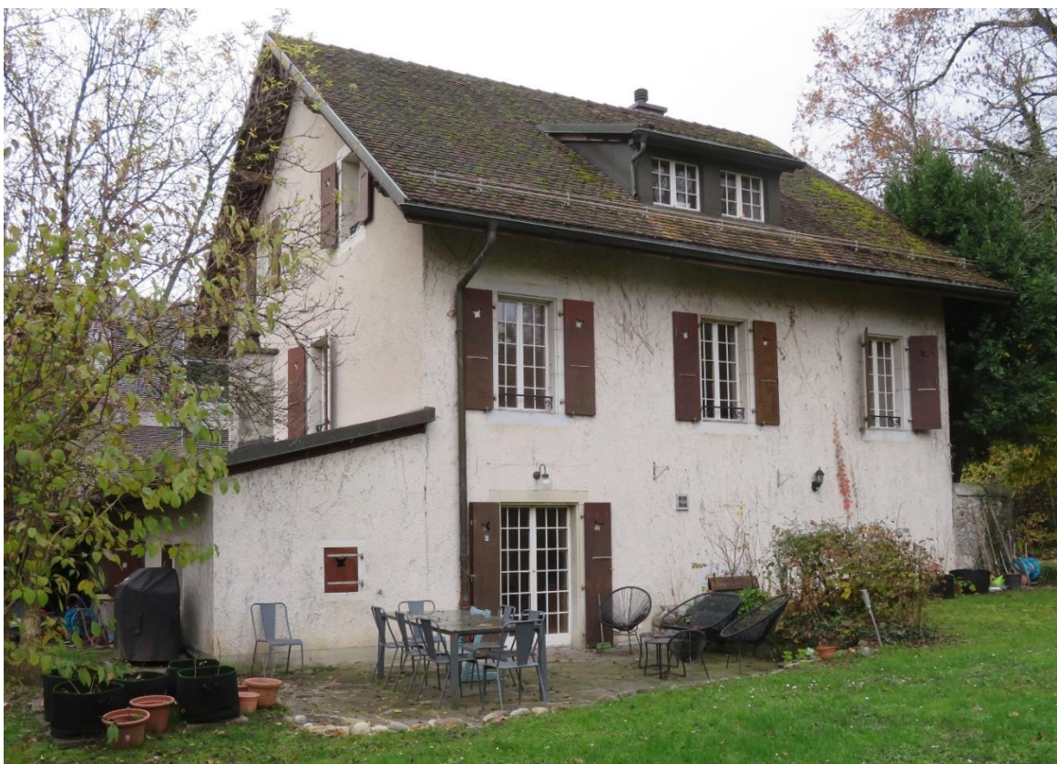
Fig. 20. Maison ch. de Prélaz 17, faces nord et est (novembre 2025).
