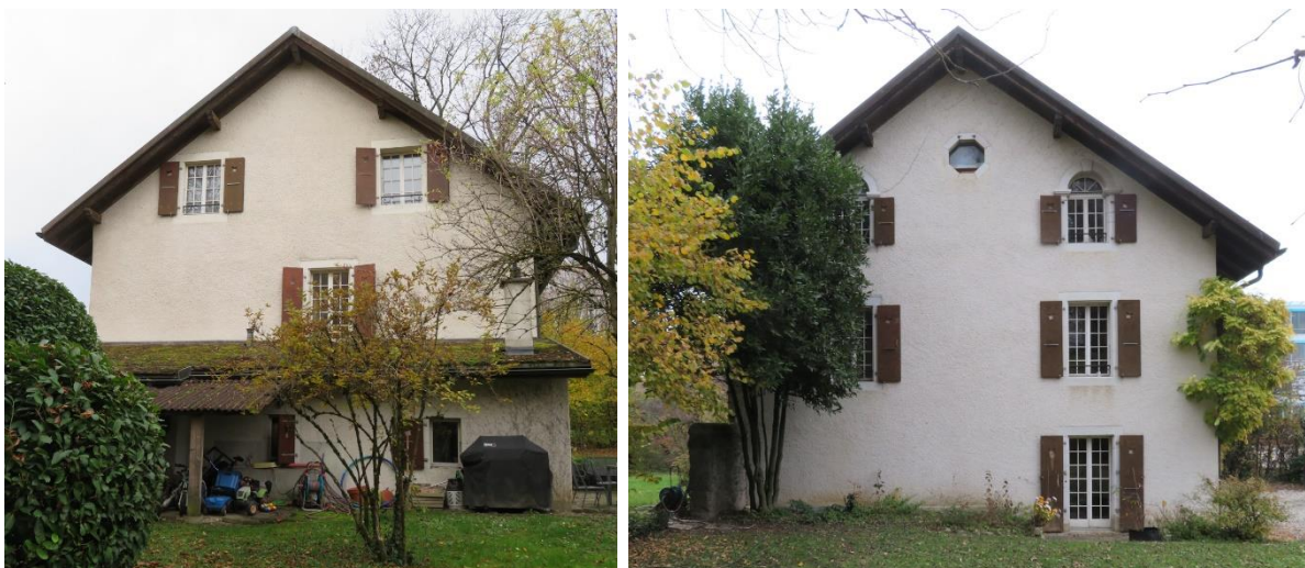
Fig. 21. Maison ch. de Prélaz 17, faces est et ouest (novembre 2025).
