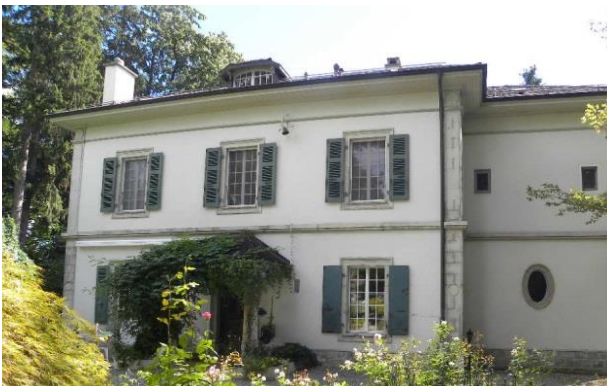
Fig. 28. Chemin de Prélaz 27, face nord (RAC, fiche 471, 2010).
