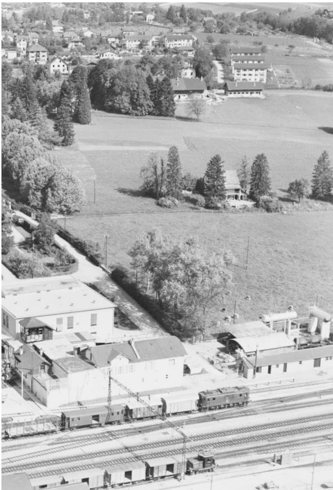
Fig. 9 bis. La parcelle 643 en 1952 (Archives cantonales vaudoises, PP 961/2749, photo Aéroport de Lausanne, détail). La maison Prélaz 17 possède alors une galerie au sud. A l'arrière-plan, les bâtiments agricoles et une série de logements collectifs toujours présents aujourd'hui.
