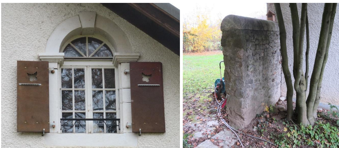
Fig. 22. Fenêtre en forme de serlienne, face ouest, et ancien mur de clôture à l'angle nord-ouest (novembre 2025). Le style néo-classique appliqué à certaines fenêtres indiquerait une date de construction antérieure à la fin du XIX e siècle, plutôt dans la première moitié du XIX e siècle.
