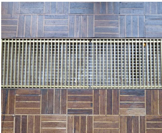
Fig. 66. Parquet et grille de ventilation.
