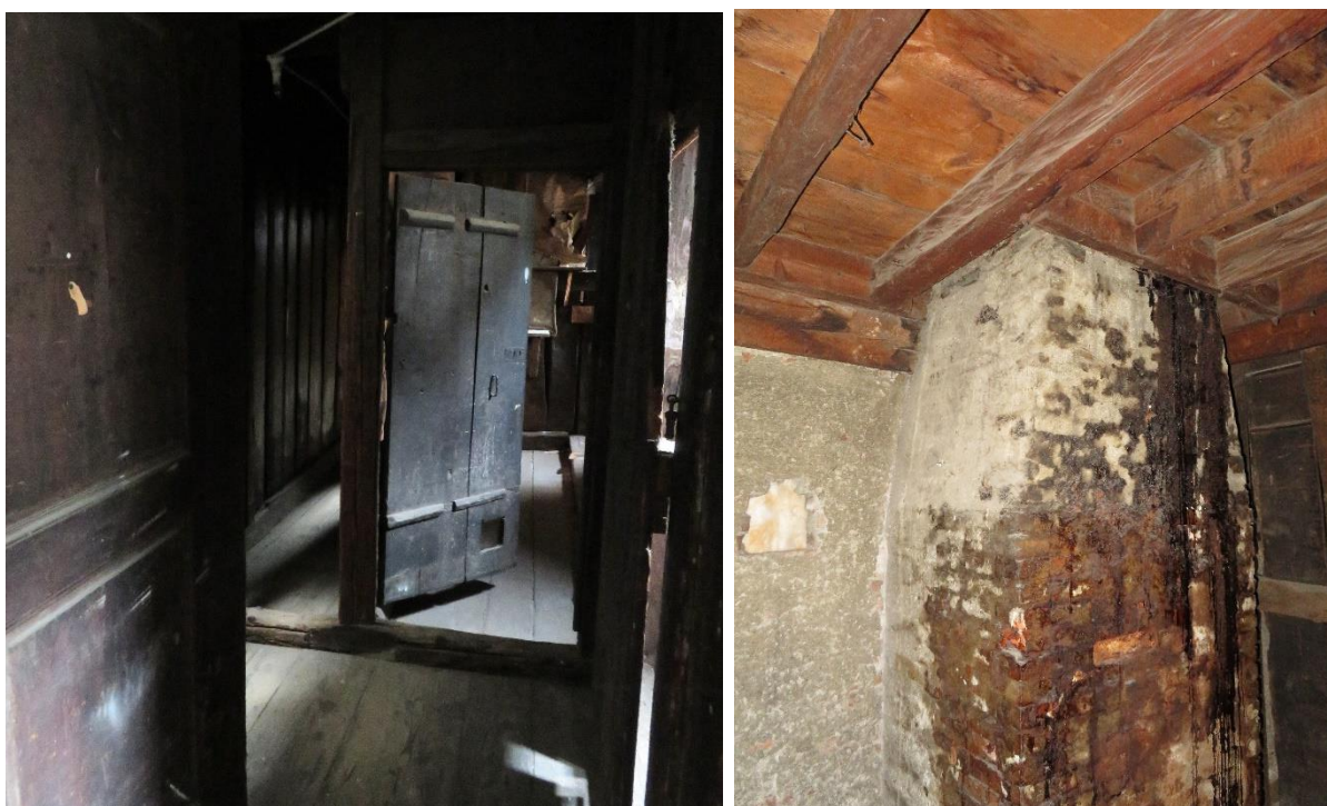
Fig. 39. Combles, parois en bois et souche de cheminée.
