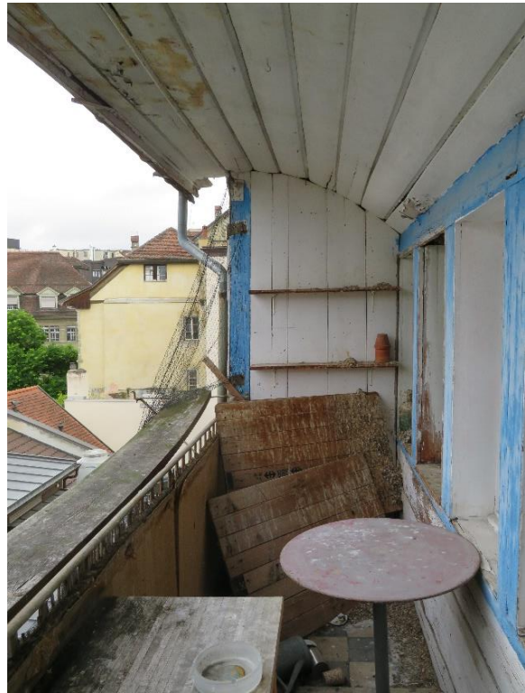
Fig. 23. Façade arrière, galerie du 4 e étage.
