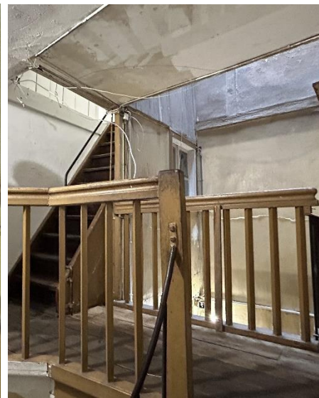
Fig. 29. Passerelle donnant accès à un cabinet, renforcée par des dins métalliques, au 2 e étage, et passerelle en bois au 4 e étage, XVII e ou XVIII e siècle.
