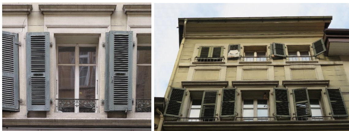
Fig. 21. Façade est, fenêtre du 1 er étage et fenêtres du 3 e et 4 e étages.
