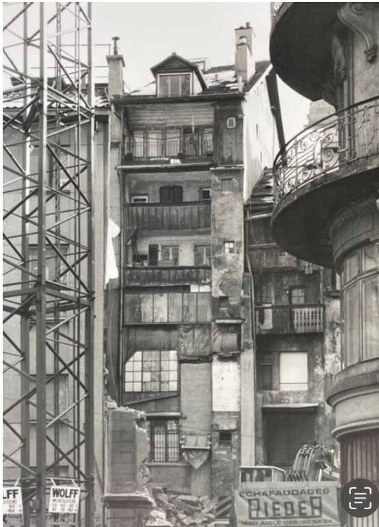
Fig. 22. Façade arrière en 1985, aujourd'hui cachée par les bâtiments rue du Petit-Saint-Jean 5 et 7.
