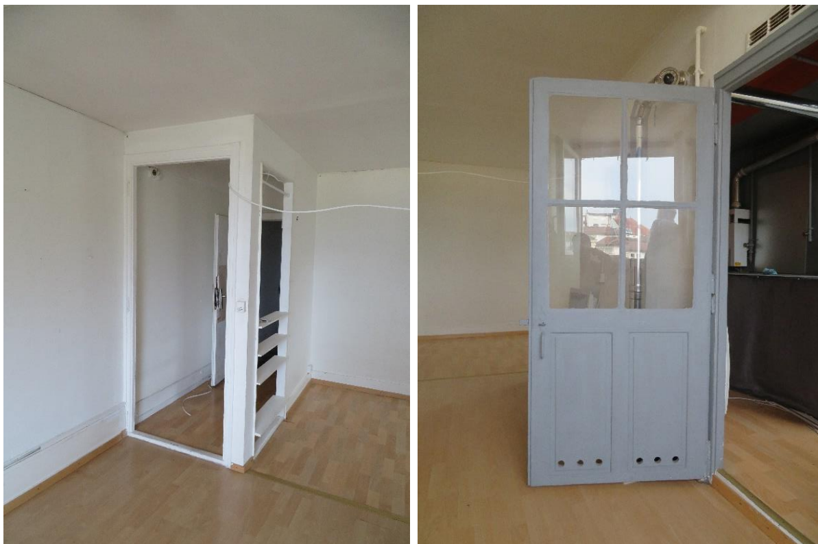
Fig. 38. Combles, partie ouest.
