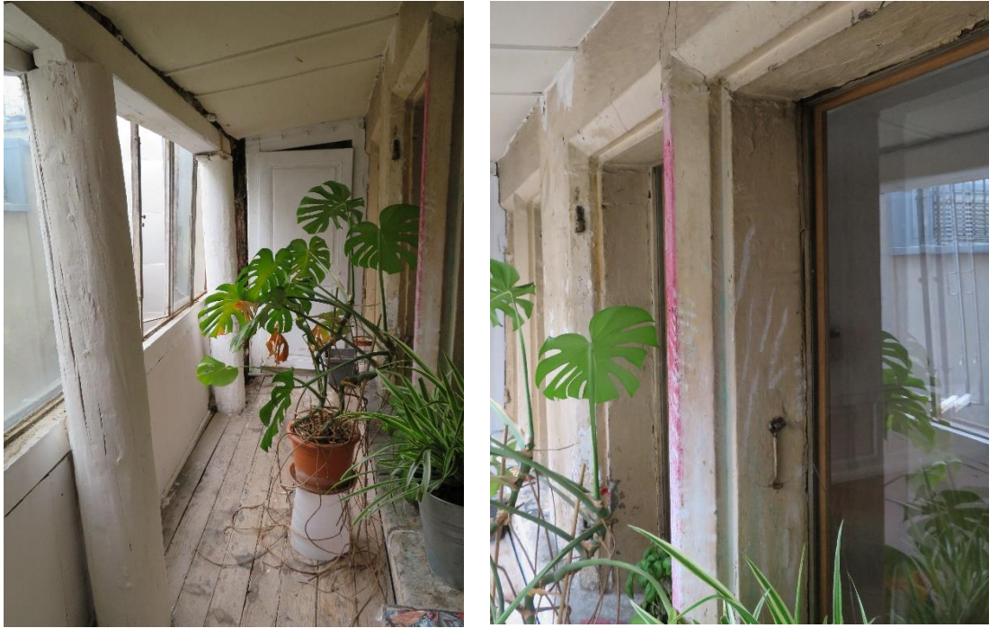
Fig. 24. Façade arrière, galerie du 1 er étage avec fenêtres de style gothique.
