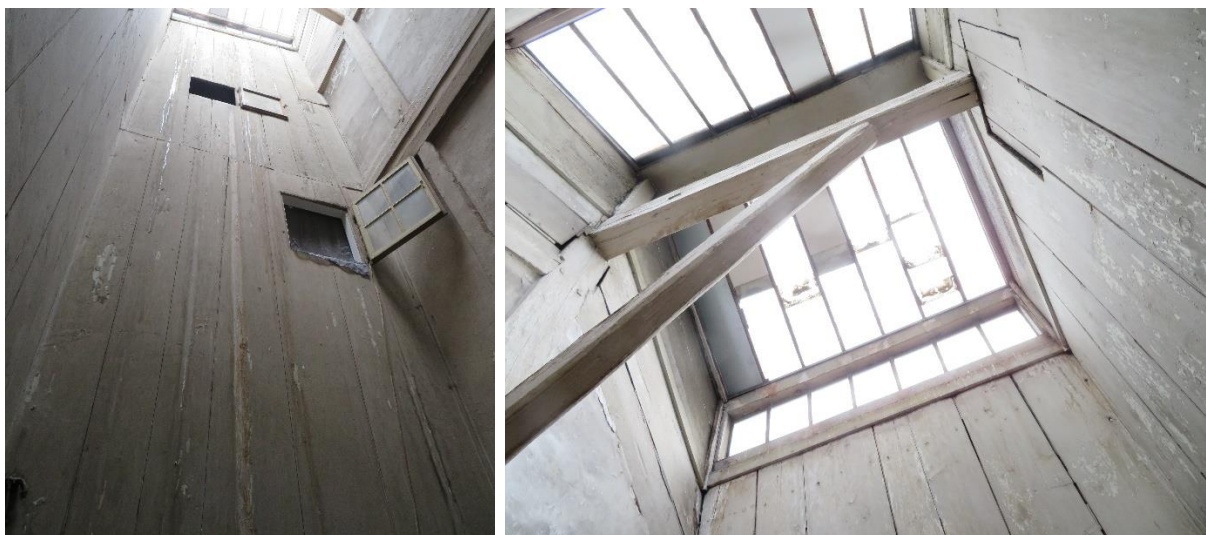
Fig. 30. Puits de lumière au niveau des combles et des sur-combles, avec fenêtres d'aération et verrière. A noter le bardage et les pans de bois.
