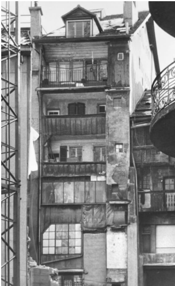
Fig. 8. Bâtiment rue du Pont 12, façade ouest, 1985. Photo prise au moment de la reconstruction de l'immeuble rue du Petit-Saint-Jean 5-7.
