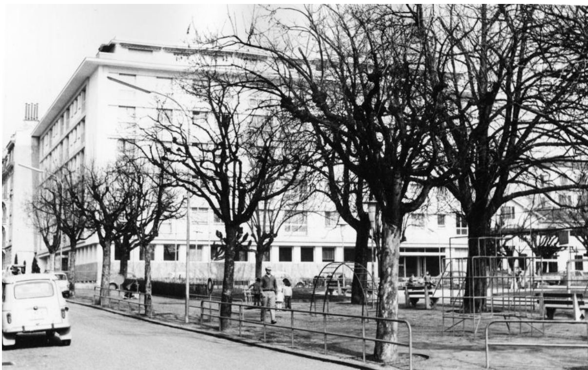
Fig. 17. Le nord-est de la place en 1971 après les aménagements de 1964 (MHV, Direction des travaux, 3982). A cette occasion, le nombre de jeux pour enfants a été augmenté et des barrières ont été posées pour les protéger de la circulation.
