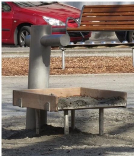
Fig. 35. Point d'eau central, en remplacement de l'ancienne fontaine.
