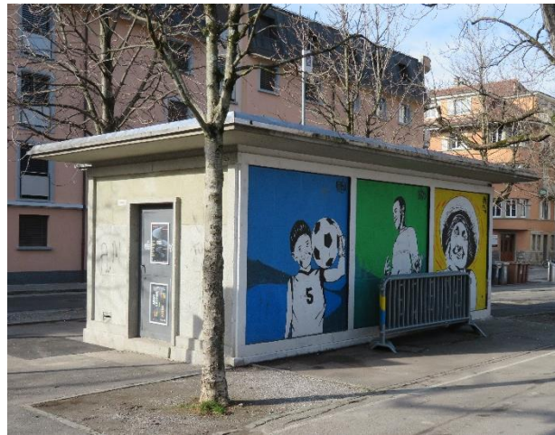
Fig. 15. Station électrique construite en 1954 à l'ouest de la place.
